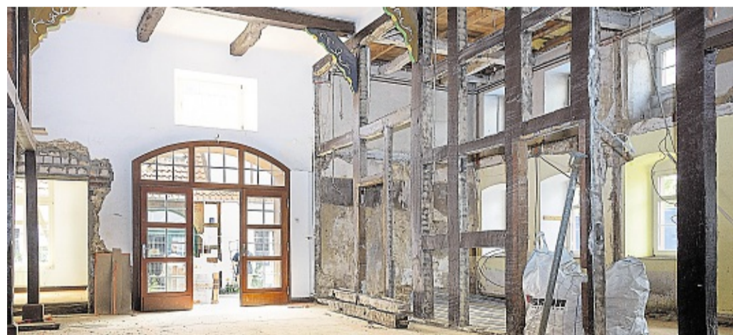
Das historische Hauptgebäude wird modernisiert.
