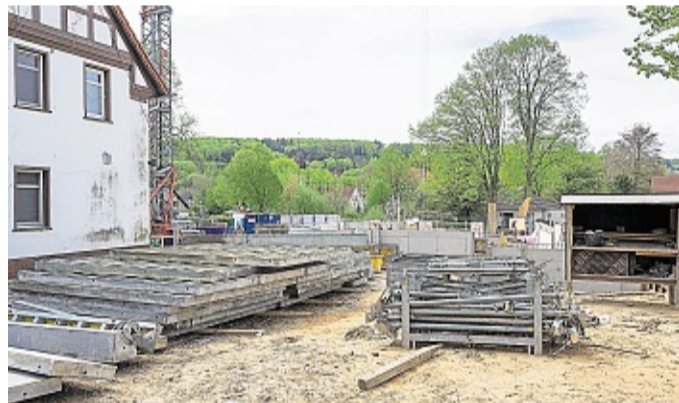
Das neue Akademiegebäude wächst.
