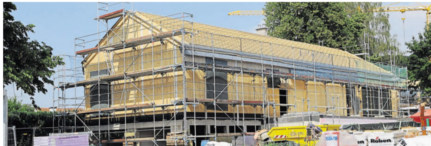
Der Rohbau des Akademiehauses in Barkhausen steht.
