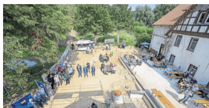
Eine besondere Perspektive auf das Geschehen beim Richtfest am Schullandheim in Barkhausen.
